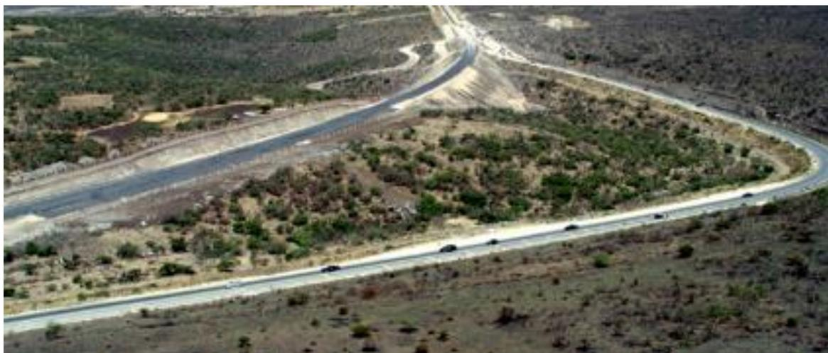
**Figura 1 – Rectificación de curva peligrosa.**
