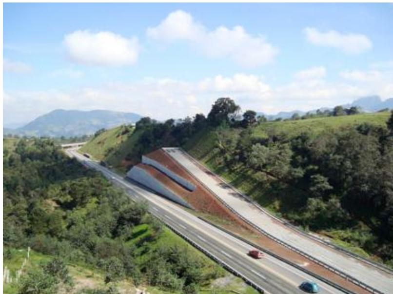
**Figura 3 – Rampa de frenado de emergencia.**
