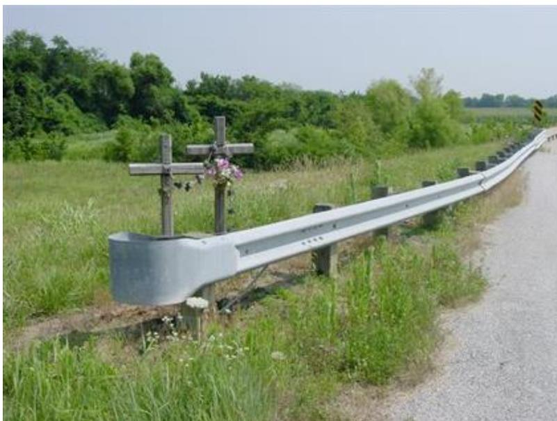
**Figura 2 – Barrera metálica con terminación peligrosa.**
